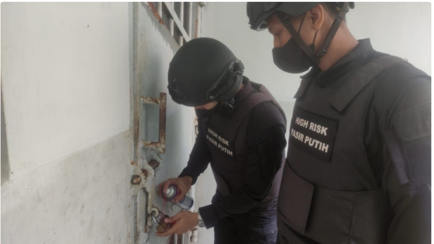
Petugas melaksanakan perawatan sarpras keamanan cegah korosi
