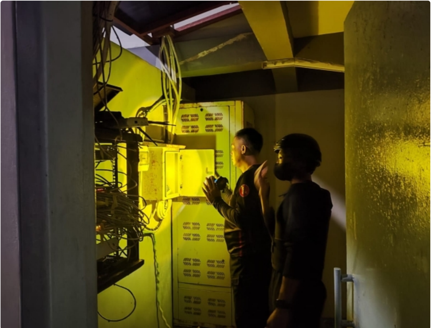
Petugas Lapas Pasir Putih lakukan pengecekan dan perawatan rutin CCTV
